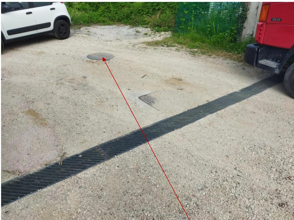
Strada laterale a Via Vicenza – Dettaglio griglia e pozzetto per ispezione fognatura
